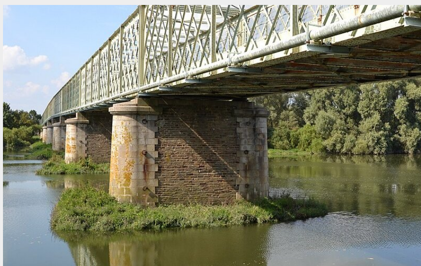
le pont nord de Thouaré-sur-Loire sur la Loire (Glabb - Wikimedia Commons - CC BY-SA 3.0)
